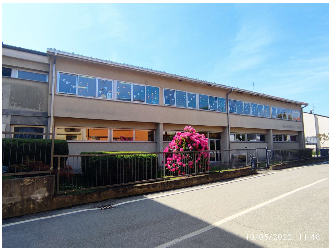
Foto 5 - Prospetto Nord su Via Stazione, non oggetto di intervento
